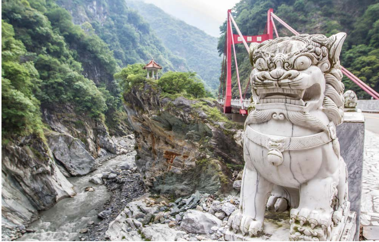
Ci En Bridge
